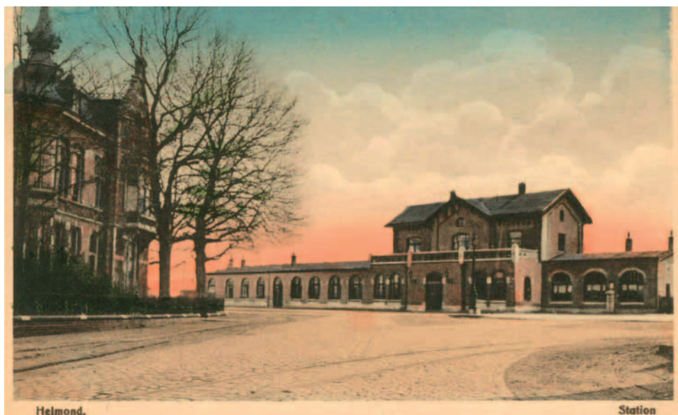
Het Stationsplein rond 1920 met villa Holtus (links) en het station na de uitbreiding. Het gebouw werd vooral aan de oostzijde (links) uitgebreid. Ook kreeg het een nieuw voorportaal en werd de overkapping aan de spoorzijde verlengd. (Collectie Utrechts archief)
